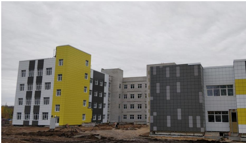
Школа на 1224 места по адресу: ул. Ильюшина, 13
