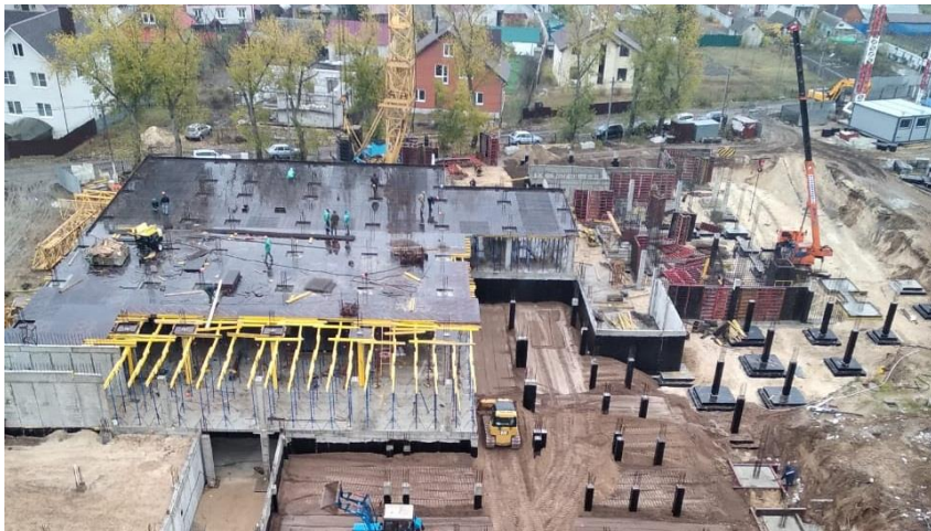
Школа на 1101 место по адресу: ул , Ф. Тютчева, 6
