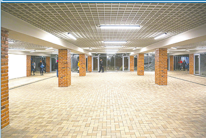
Реконструкция подземного перехода у Цирка
